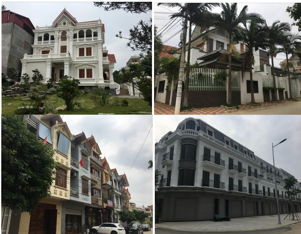
Hình 3: Nhà ở liền kề, biệt thự khu vực trung tâm thành phố Lạng Sơn
