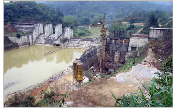
Hình 24: Nhà máy thủy điện Bắc Giang - Huyện Bình Gia
